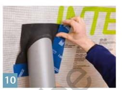
Si des conduits ou câbles traversent la couche d'étanchéité à l'air, ils doivent également bénéficier d'un raccord durable et fiable. Les manchettes d'étanchéité à l'air en EPDM y conviennent parfaitement. Le matériau souple
