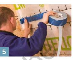
Au niveau du chevauchement, coller les membranes à l'aide du ruban adhésif TESCON No.1 ou TESCON VANA de manière à ce qu'il ne subisse aucune traction ni charge. Les plis au niveau du chevauchement ne peuvent pas être collés, mais doivent d'abord être coupés et aplanis avant
