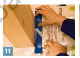
L'étanchéité à l'air est également importante aux endroits avec plusieurs coins. Elle ne pose aucun problème avec le ruban adhésif d'angle TESCON PROFIL. Celui-ci possède trois bandelettes de film transfert séparées. Cela permet de dénuder
