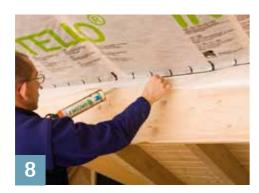
Sur les chevrons ou pannes à surface rugueuse, utiliser la colle de raccord ORCON F. Appliquer ORCON F en un cordon d'un diamètre d'env. 5 mm. Sur les supports rugueux, agrandir éventuellement le diamètre du cordon de colle.
