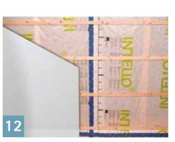
Un contre-lattage posé du côté intérieur, avec un écart maximal de 50 cm devrait soutenir le poids de l'isolant. Les revêtements intérieurs protègent les membranes des dégâts et des rayons ultraviolets.
