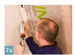
Pour le raccord au mur pignon enduit, appliquer directement la colle de raccord tout usage ORCON F avec la cartouche, en un cordon d'un diamètre d'env. 5 mm. Sur les supports rugueux, augmenter éventuellement le diamètre du cordon de colle.
