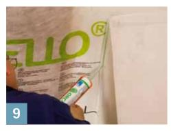
Pour les raccords à des cheminées isolées à double enveloppe, laisser dépasser INTELLO d'env. 3 cm sur la cheminée. Appliquer un cordon de colle ORCON F d'un diamètre d'env. 5 mm (ou davantage) et poser la membrane avec une boucle de dilatation dans le lit de colle. Ne pas écraser complètement la colle.
