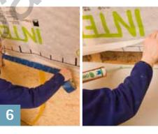
Les raccords aux éléments de construction adjacents sont tout aussi importants que le collage des chevauchements. Si ces éléments sont lisses et non minéraux (comme ici des jambettes en panneaux OSB), les raccords se font avec TESCON No.1 ou TESCON VANA. Idem pour les raccords à un mur pignon.
