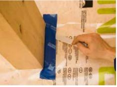
d'abord seulement une partie de la surface adhésive et d'effectuer un côté du collage. Dans un second temps, il suffit alors d'enlever les bandelettes de transfert restantes pour achever le collage.
